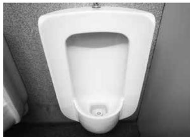
尿石（おしっこ飛散含む）によるアンモニア臭が匂いの原因です。酸性洗剤を使用し除去することで匂いを取り除くことができます。匂いがする場合に確認するポイントになります。
