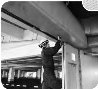
▲シャッターの動作確認中。
