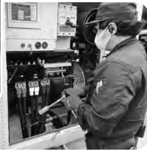
▼発電機も点検します。
