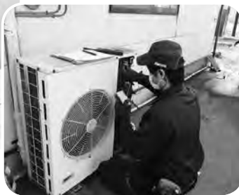
▼空調機もしっかり点検。
