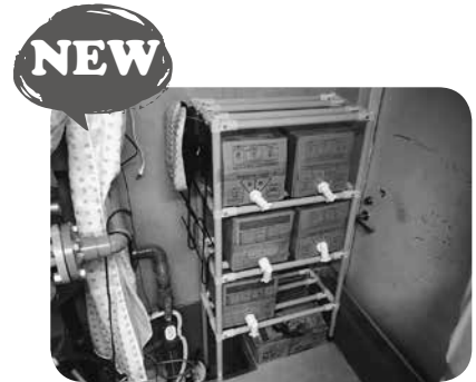
初 [フィットネスクラブ広尾] 優 [資生堂銀座ビル] 初 [国際興業本社ビル]
