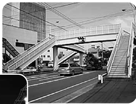
▲千葉県某市歩道橋(防錆工事)
