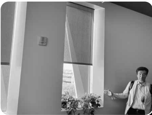
▲計算された採光 太陽光の取り入れを最低限とし、空調エネルギー効率を高めている
