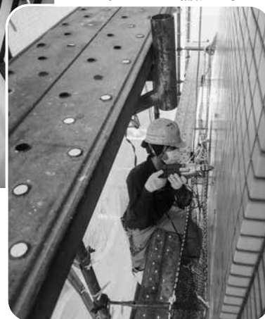
▼ 外壁タイル補強工事
