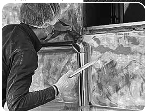
▼ セントラルキッチン： 壁面防カビ塗装工事
