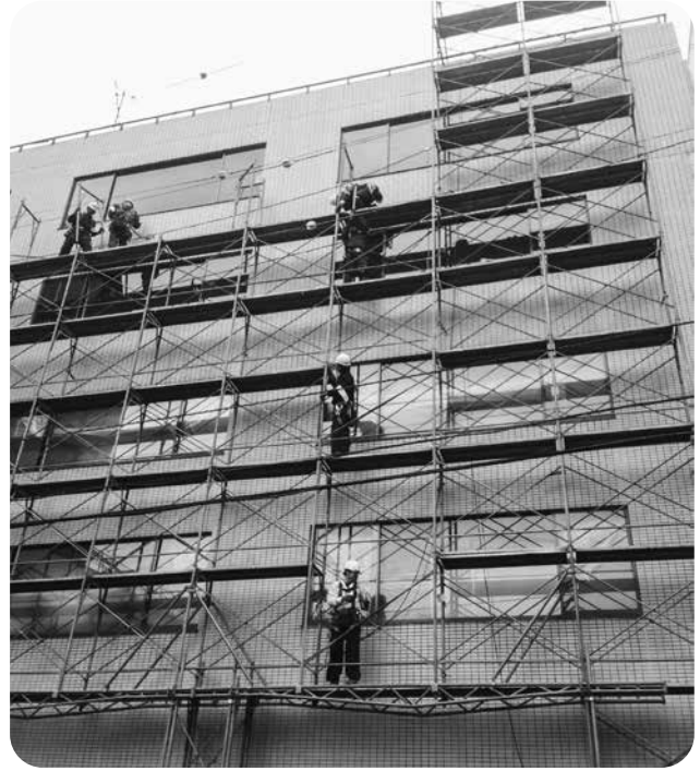
▲外壁改修工事
