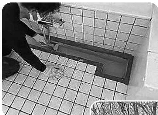
▲ 温浴：排水溝補強工事
