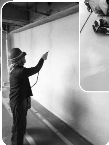
▶ 屋内壁面吹付塗装工事
