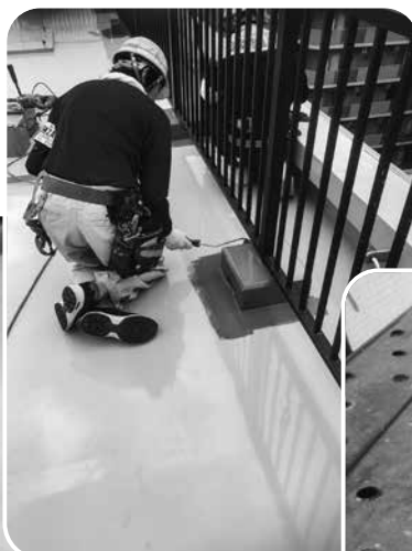
◀ 屋上防水工事
