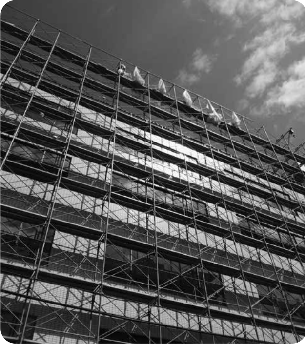
▲足場組立 安全第一
